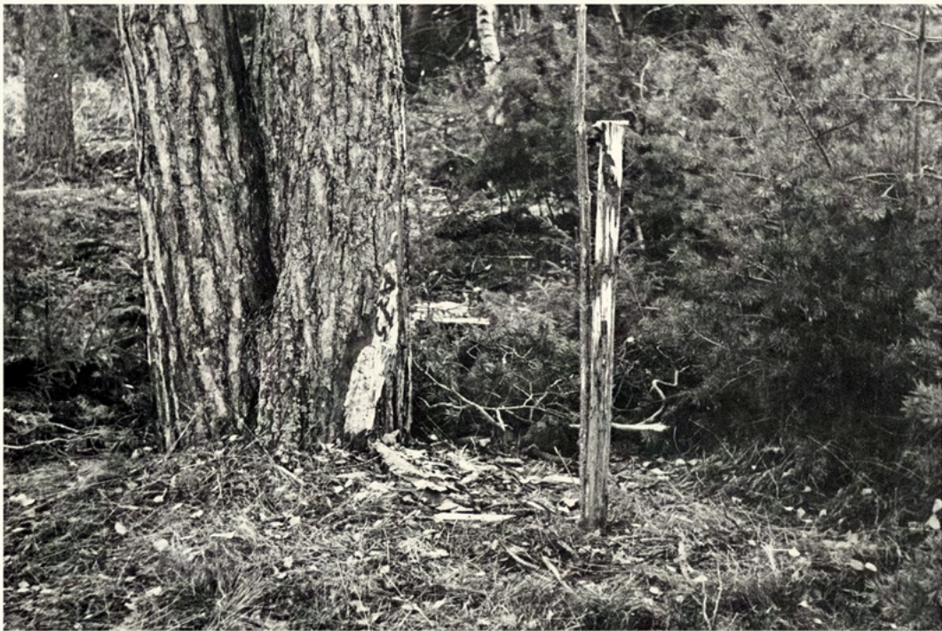
Primera baliza señalizadora para la construcción de la Central Nuclear de Leningrado.
